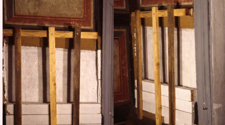
Rahmenstruktur zum Abstützen der Balken
