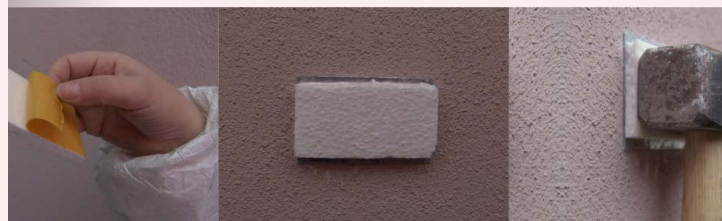
Styropor als Trennschicht
