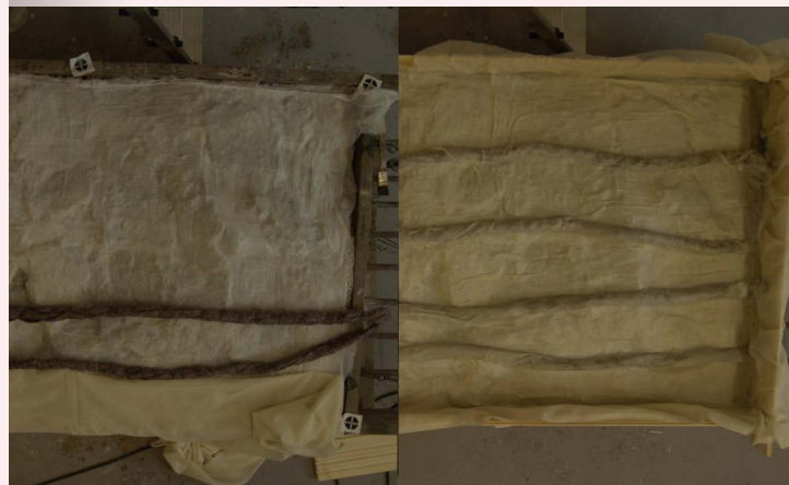
Einbau der Drainagestreifen und Kaschierung mit Baumwollnessel
