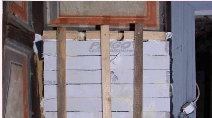
Schalung aus PU-Platten
