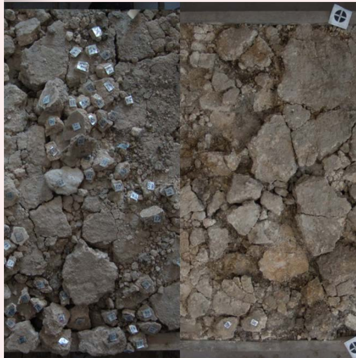
Anweichen der harten Lehmschicht Freilegung der Putzflächen
