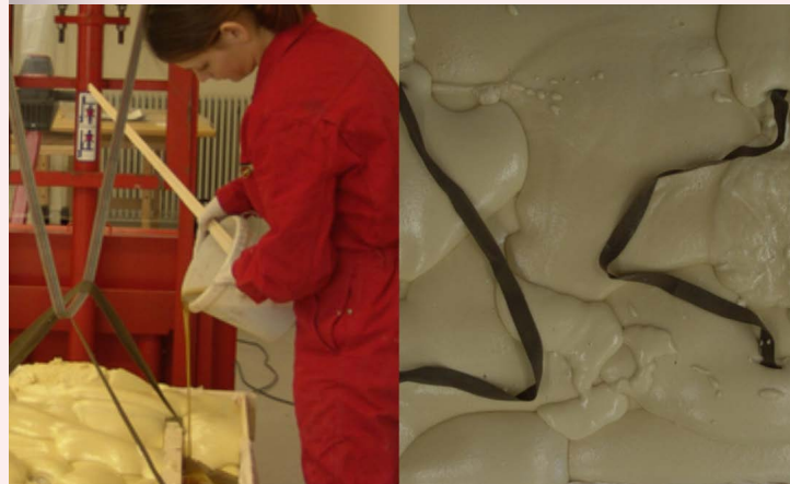
Herstellen des PU-Schaumkissen mit Holzarmierung
