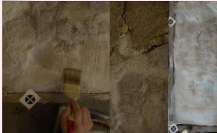
Festlegung der abzunehmenden Fragmente und Kaschierung
