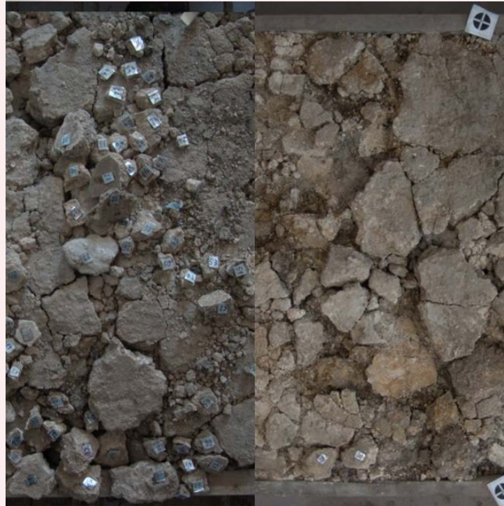
Anweichen der harten Lehmschicht Freilegung der Putzflächen
